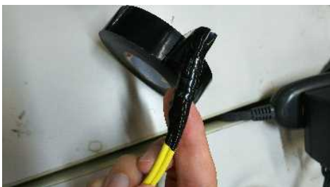
⑥下部まで折り返したら再度上部に折り返し、④と同じ工程を行う。
